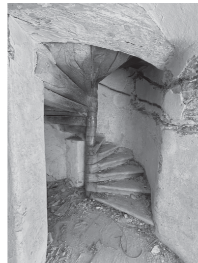
5 vretenové drevené schodisko do veže
