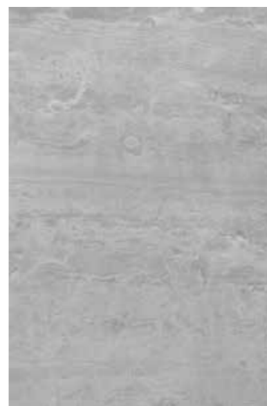
Liatý betón, navrhnutý na úpravu podlahy ktory zjenoti priestor.
