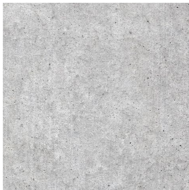
POHLEDOVÝ BETON -venkovní schodiště
