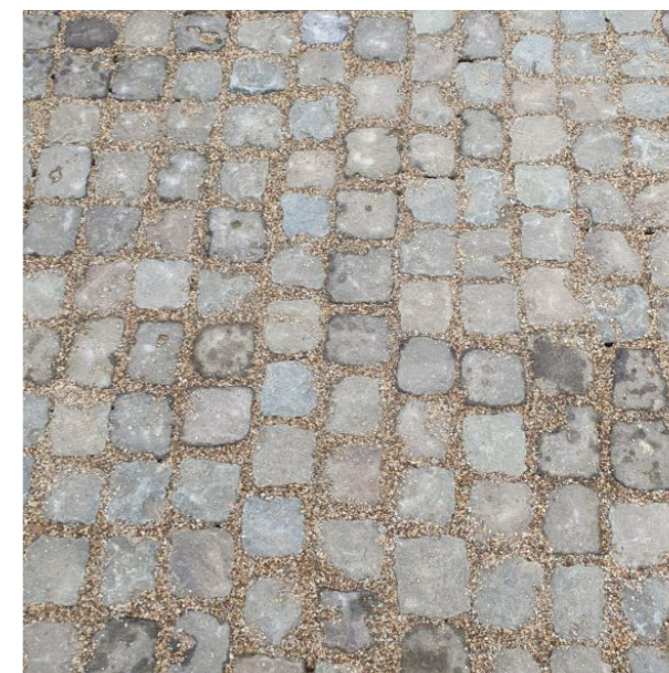
KAMENNÁ DLAŽBA - zpevněné povrchy na zahradě
