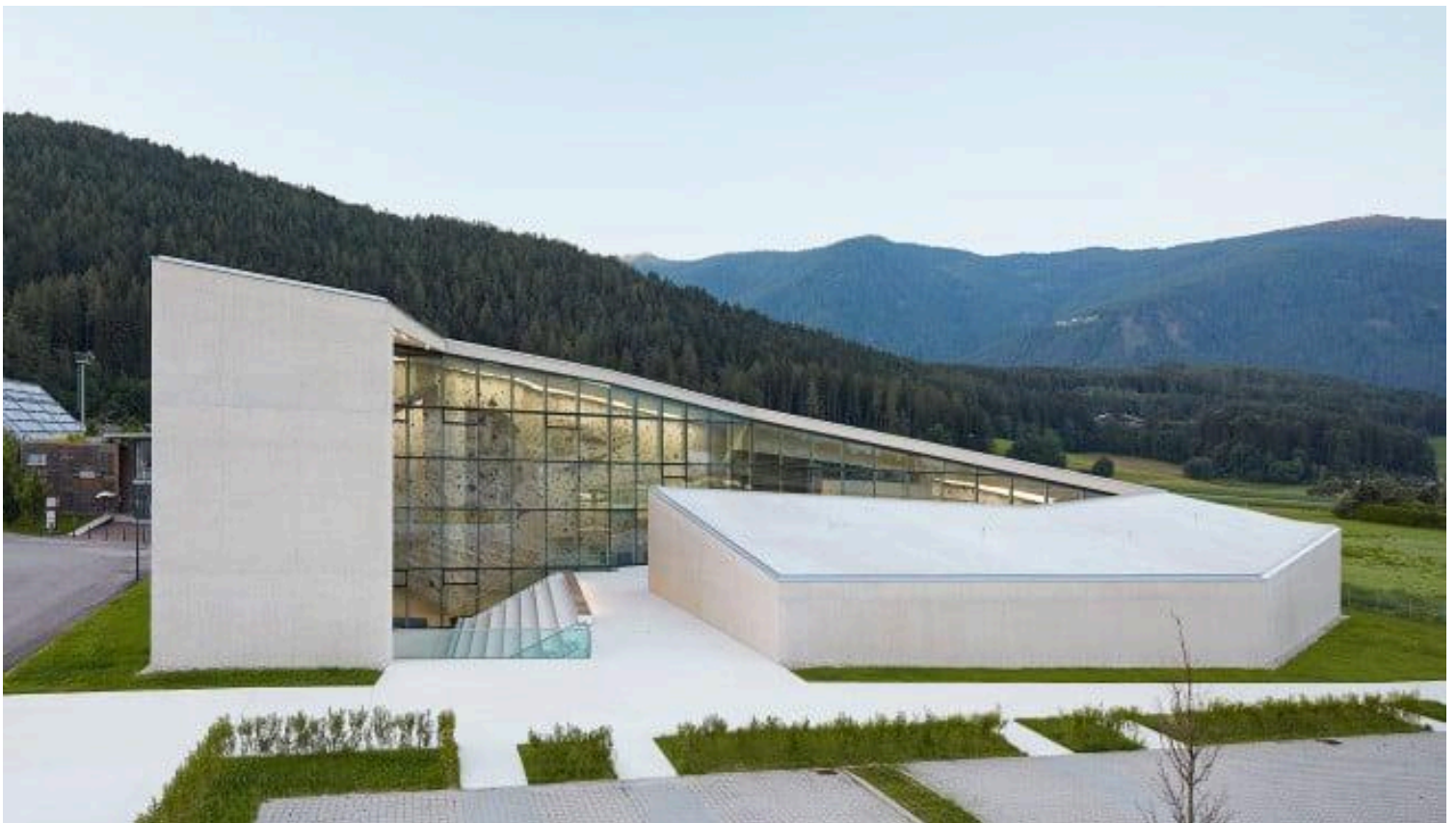
Fig. 4. Kletterhalle Bruneck, Photo by Rene Riller, Mailand (source: https://www.baunetzwissen.de/flachdach/objekte/kultur-und-freizeit/kletterhalle-in-bruneck-4704780 , retrieved 24.05.2026)
