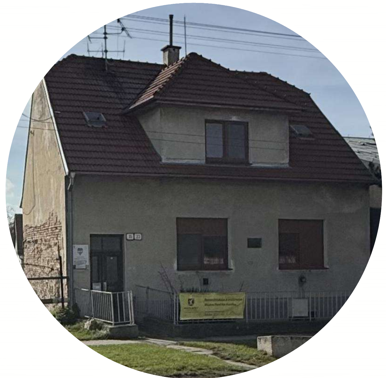
FOTOGRAFIA Z ROKU 2025, RODINNÝ DOM FERDIŠA KOSTKU, (POHLAD Z ULICE)
