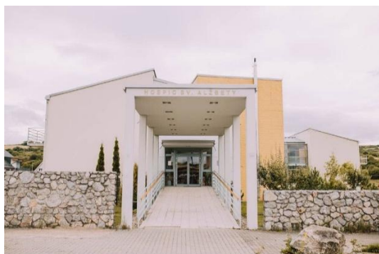
Obr. č.8 Pohľad na vstup
