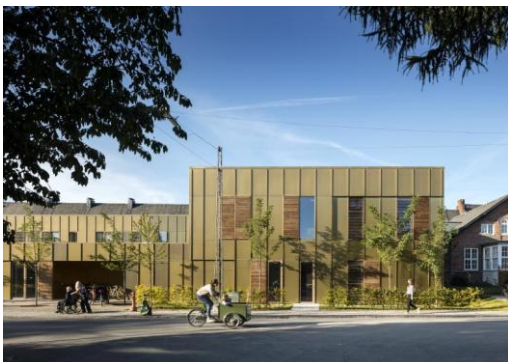
Obr. č.12 : Pohľad na vstup
