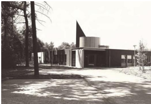
Obr. č.15 : Pohľad na vstup
