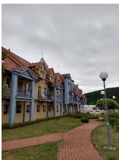
Obr. č.5 : Pohľad na vstup
