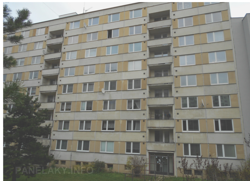
T06B s parapetním obvodovým pláštěm
