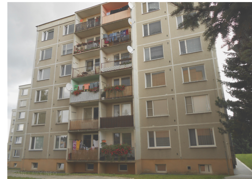
T06B s celostěnovým obvodovým pláštěm
