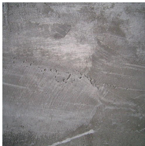
Benátský štuk např. protilehlé zdi koupelny
